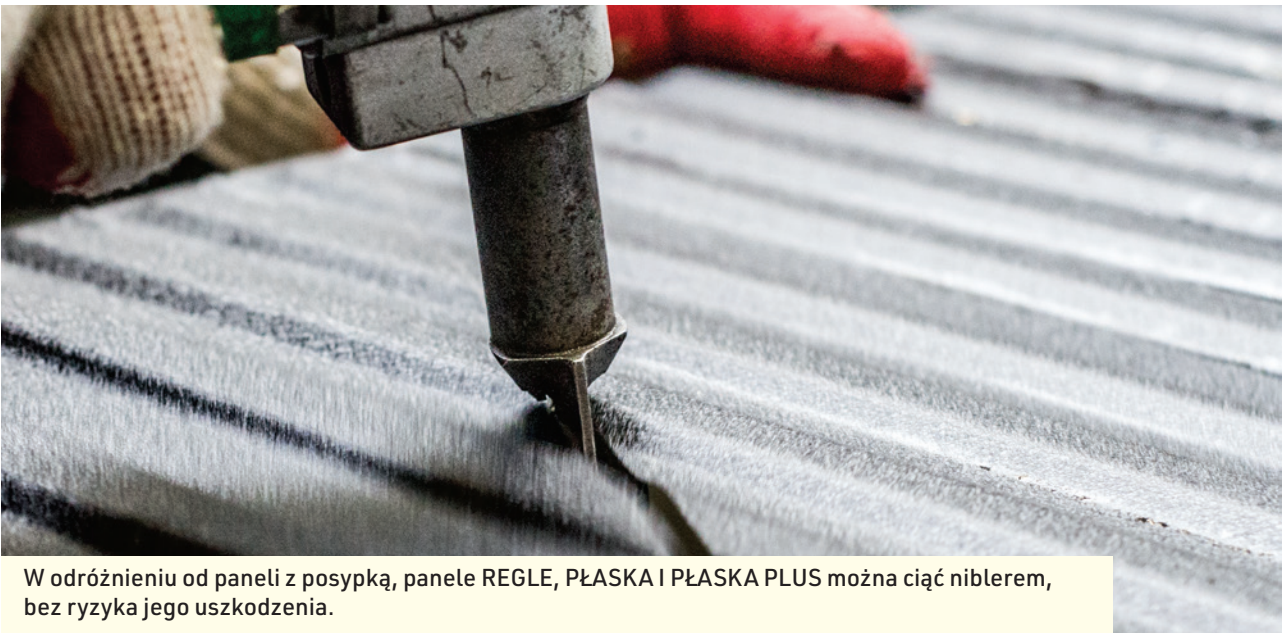
Odcinanie niepotrzebnej części panelu.
