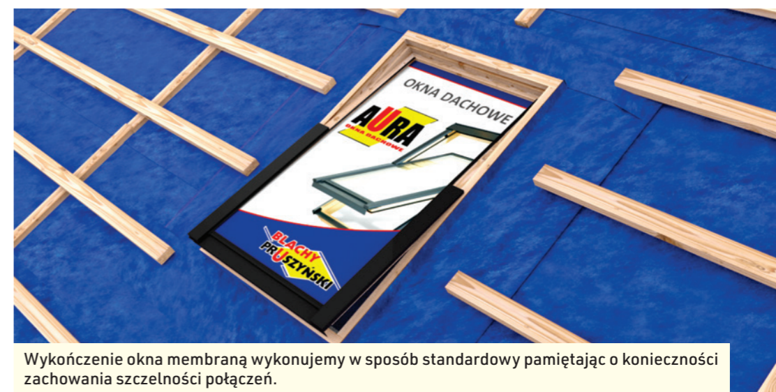
Podkonstrukcja okna dachowego
