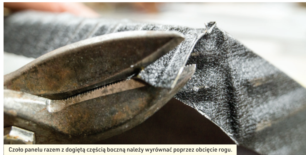
Niedociągnięcia można poprawić za pomocą szczypiec.
