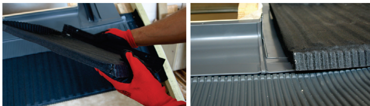
Zamontowane okno dachowe.
