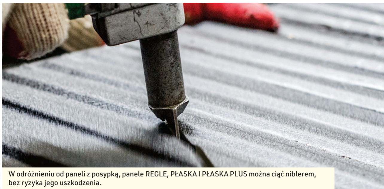
Odcinanie niepotrzebnej części panelu.
