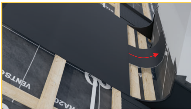
Zaginamy krawędzie oraz gumowym młotkiem „gładzimy” kawałek powstałego garbu, aby w późniejszym etapie, zamontować kolejne arkusze blachy trapezowej.
