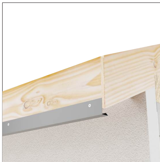
Montaż listwy startowej.
