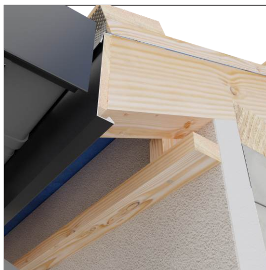
Montaż stelaża do mocowania podbitki.
