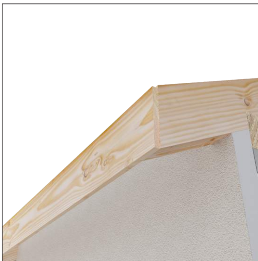
Odbiór dachu i przygotowanie do montażu systemu rynnowego i pokrycia dachowego.
