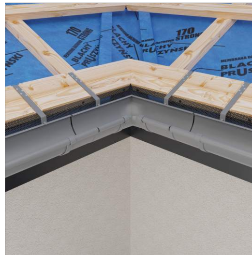
Rynny i narożnik zamontowane na hakach z zachowaniem 5-10 mm dylatacji.
