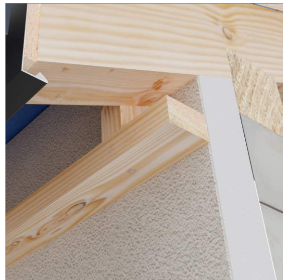
Montaż stelaża do mocowania podbitki.
