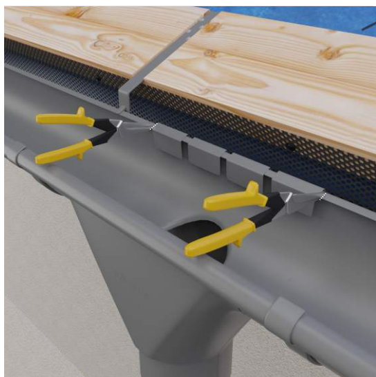
Nacięcie tylnego usztywnienia rynny za pomocą lewych/prawych nożyc - tworzenie punktów stałych sztucera, które zapobiegają jego przesuwaniu.
