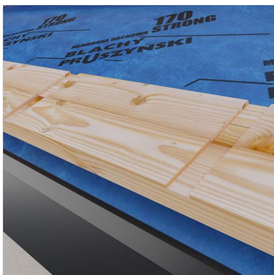
Wykonanie brzd pod haki nakrokwiowe
