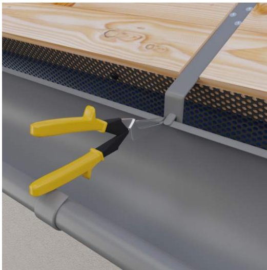
Dogięcie klipsu zabezpieczającego.
