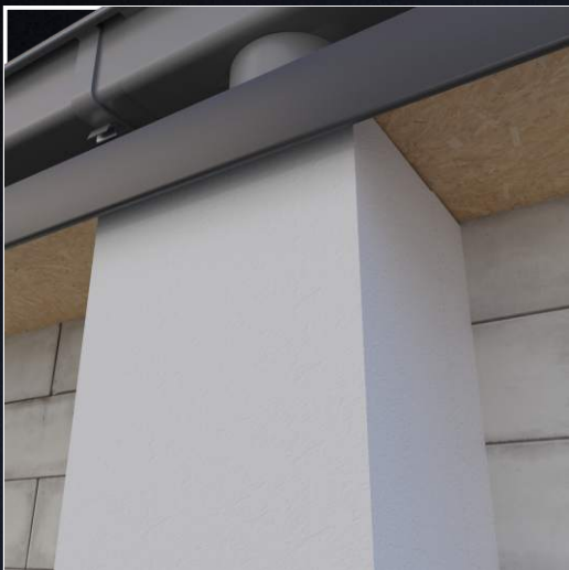
Otulina zamocowana na rurze.
