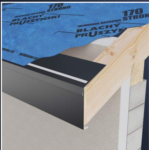
Montaż membrany dachowej na krokwiach Przyklejenie membrany do pasa podrynnowego.
