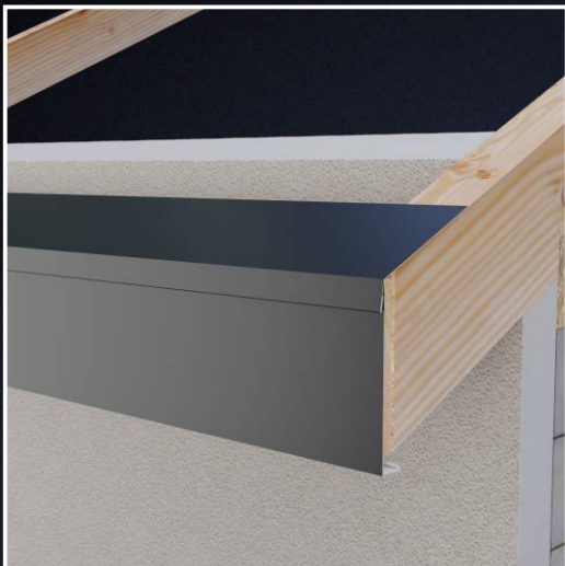
Montaż pasa podrynnowego (skroplinowego).
