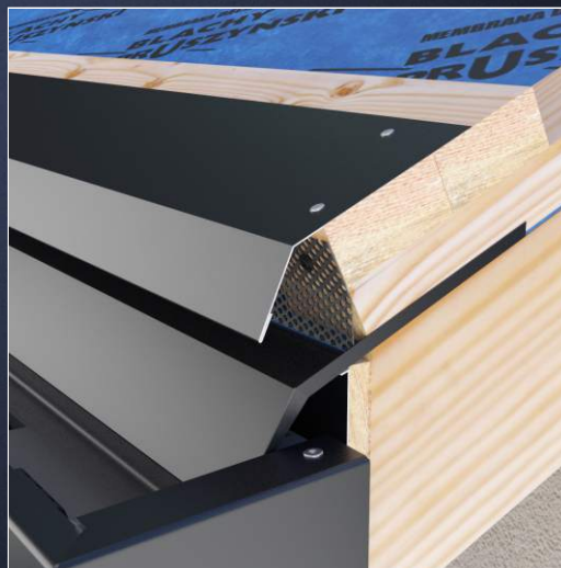
Montaż pasa nadrynnowego.
