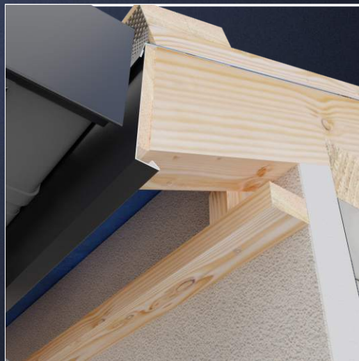
Montaż stelaża do mocowania podbitki.
