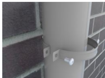
Obejmę skręcamy ze sobą wkrętami tak aby rura nie mogła się wysunąć.
