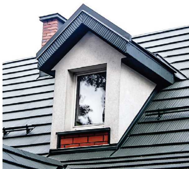
Schemat - wiatrownica górna
