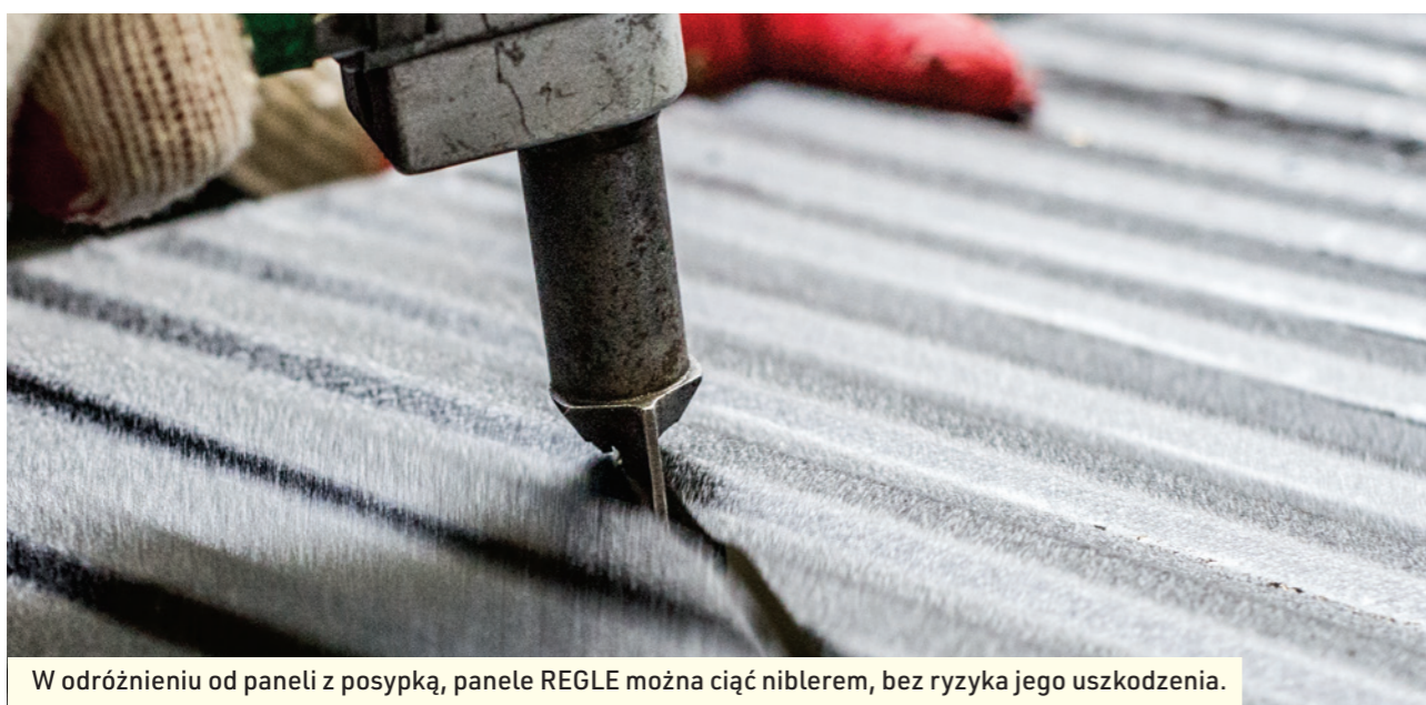
Odcinanie niepotrzebnej części panelu.
