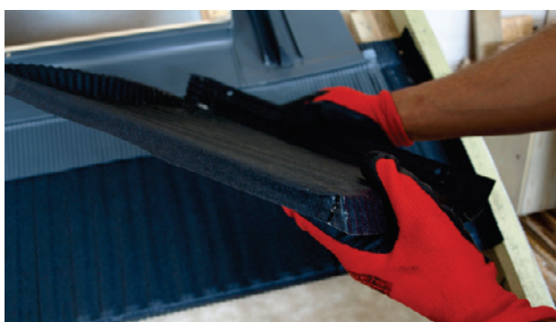
Zamontowane okno dachowe.
