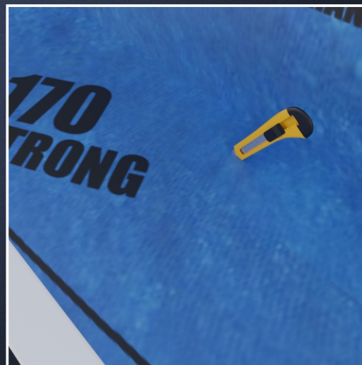
Wycinanie w membranie otworu pod spust rynny.
