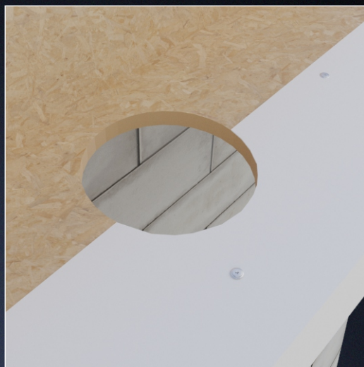
Otwór wycięty w obróbce. Obróbka zamocowana na wkręty talerzykowe
