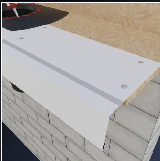
Wzglęź obróbki parapetu przyklejamy taśmę dwustronną do membrany.
