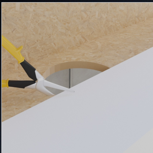
Obcinamy obróbkę gzymsu w miejscu otworu pod rurę spustową.
