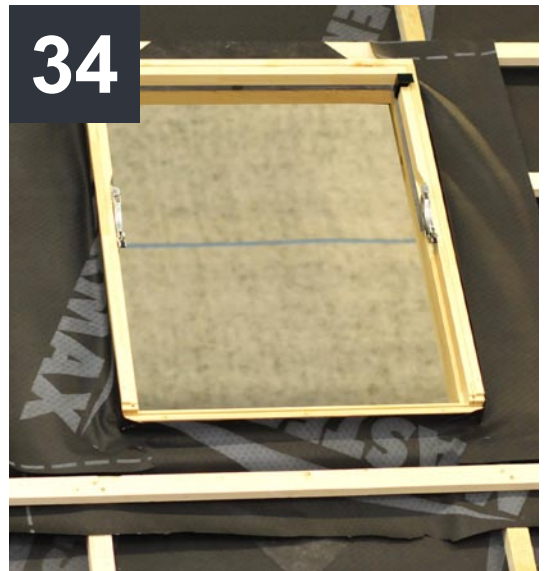
Mocowanie górnego pasa membrany.
