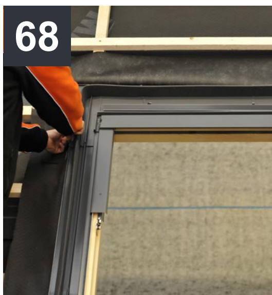
68 Ułożyć górną część oblachowania i górną część kołnierza wraz z uszczelką.
