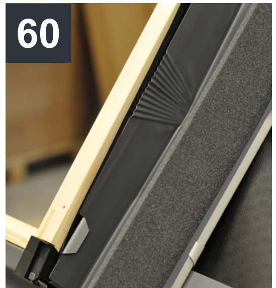
60 Widoczne przeprofilowanie pozwala zagiąć boczny element i dopasować go do wysokości kołnierza zamontowanego poniżej.
