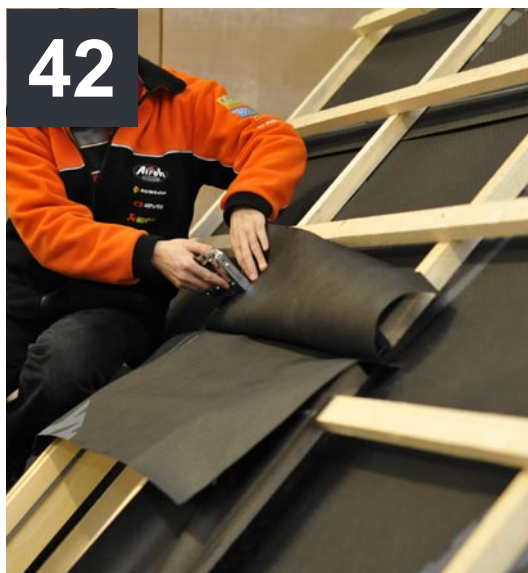
Górny kołnierz należy przymocować do łąt nad miejscem przecięcia.
