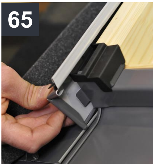
65 Boczne części oblachowania wsunąć na ościeżnicę.
