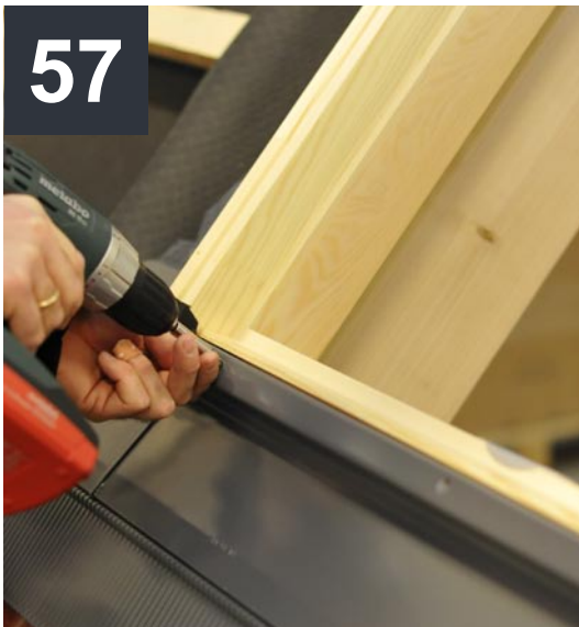
57 Za pomocą wkrętów znajdujących się w zestawie przymocować oblachowanie do ościeżnicy.
