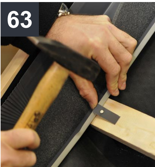
63 Przymocować boczne części kołnierza do łąt za pomocą dołączonych uchwytów montażowych.
