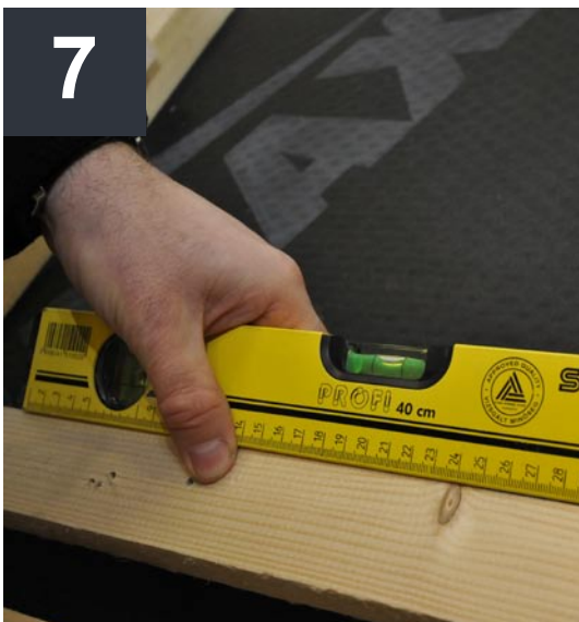
Mocowanie łąty montażowej.
