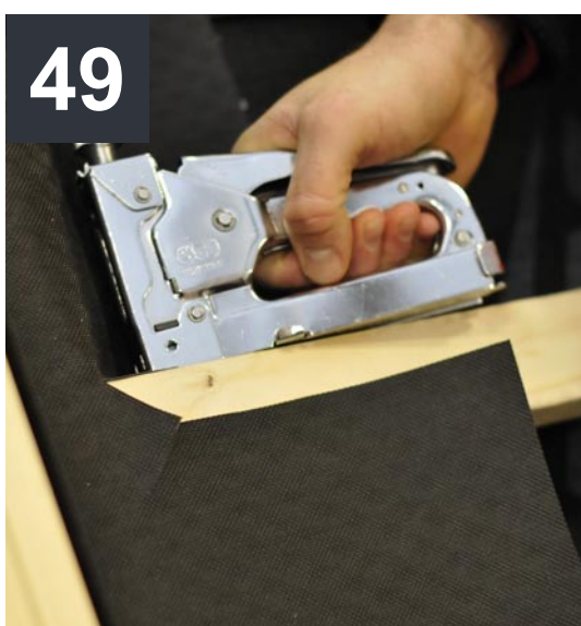
Mocując boczne paski membrany sprawdzić, czy są dobrze wycięte i ciasno przylegają do łąt.
