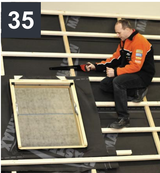
Istotne jest, aby górny pas wsunąć pod istniejącą membranę dachową.
