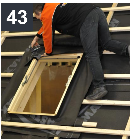
Dolną część przymocować do ramy ościeżnicy.
