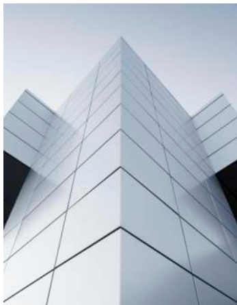
Zdj. 2. Elewacja wykonana z kasetonów
