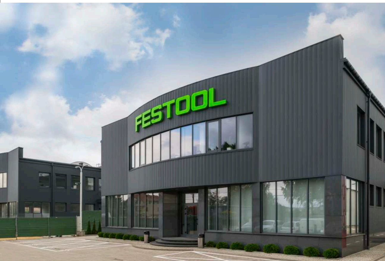
Zdj. 4. Elewacja wykonana z paneli PS
