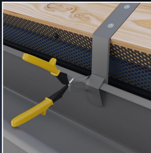
Tworzymy punkt stały dylatacji poprzez nacięcie tylnego usztywnienia rynny po obu stronach najbardziej środkowego haka używając lewych i prawych nożyc. Punkt stały środkowego haka powoduje skrócenie dylatacji o połowę.
