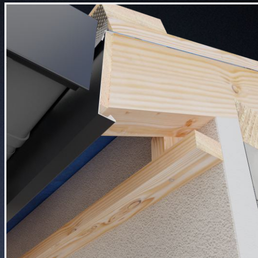
Montaż stelaża do mocowania podbitki.
